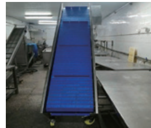
The hoist installed 提升機已安裝完成
