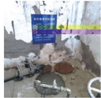
公司水源井封井
