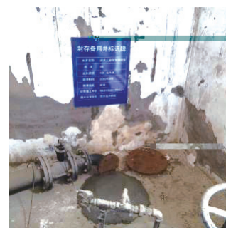
公司水源井封井
